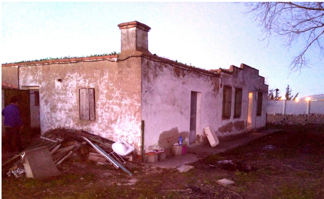
Fachadas suroeste y sureste. A la izquierda acceso al corral-patio. A la derecha acceso a la vivienda.
