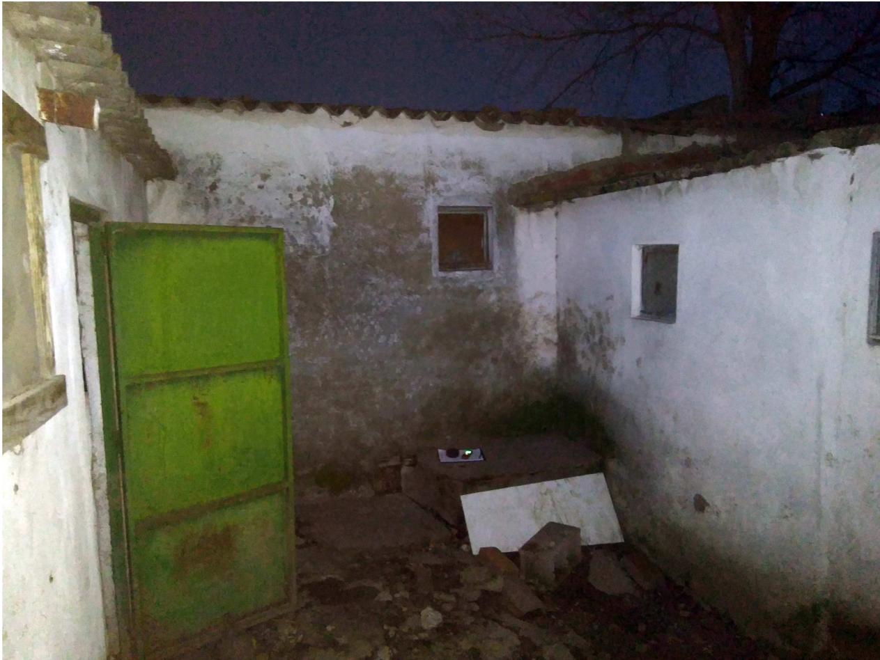
Corral-patio desde el acceso. A la izquierda acceso a las cocheras.
