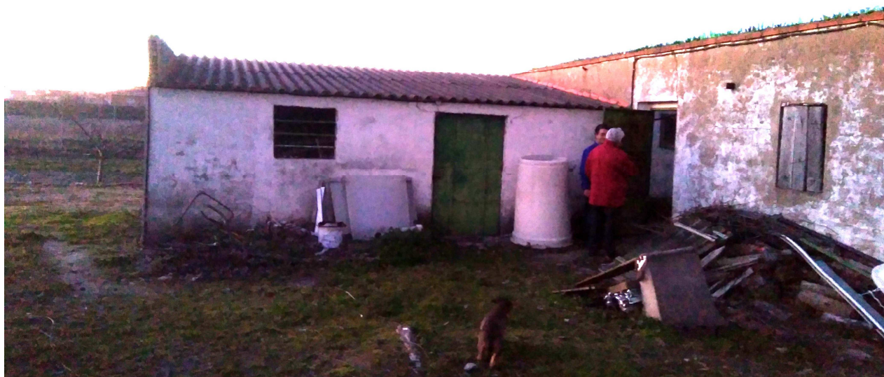
Almacén. Fachada sureste. Accesos al almacén y al corral-patio.
